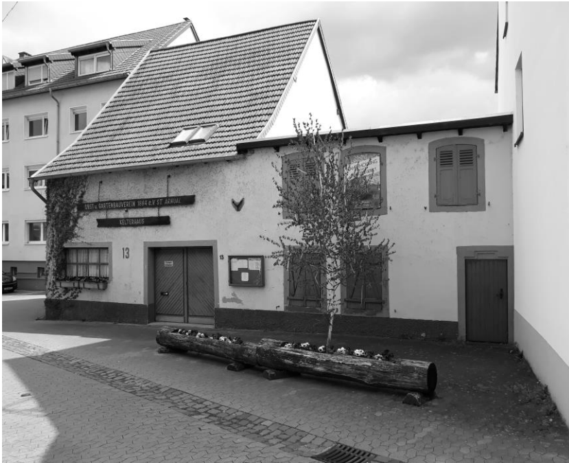
Kelterhaus des OGV in der Pfälzer Str. 13
