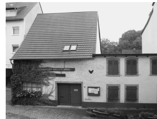
Kelterhaus, 1708 als Bauernhaus erbaut, steht als Einzeldenkmal unter Denkmalschutz
